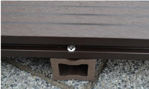
Zakończenie montażu przy użyciu wkrętu zamocowanego pod kątem do legara
